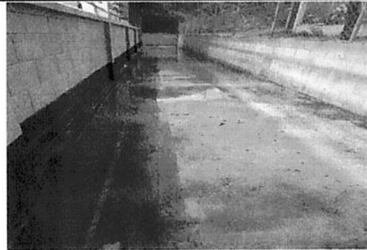
Reparacion de muro perimetral
