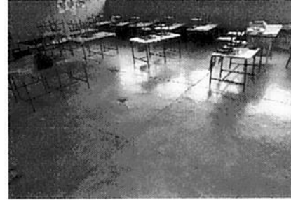
Sustitucion de piso en aulas
