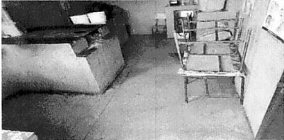
sustitucion de piso ceramico en cocina
