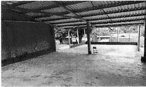
Sustitucion de piso en salon de usos multiples
